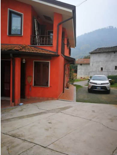
3 vista della parte 'b' già recuperata
