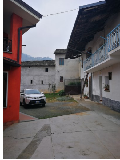
3 vista del cortile e della parte 'a' da recuperare fronte sud-sud/est
