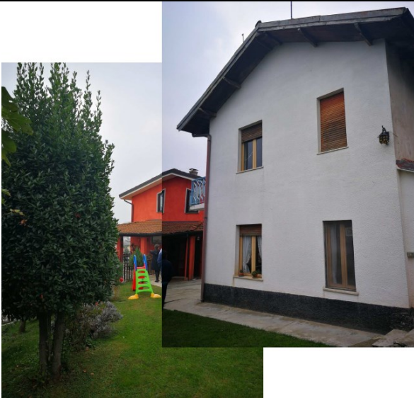
4 vista della parte da recuperare con parte a verde antistante in piano
