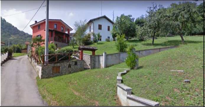
1 vista dal bivio sulla SP304 del complesso dell'area
