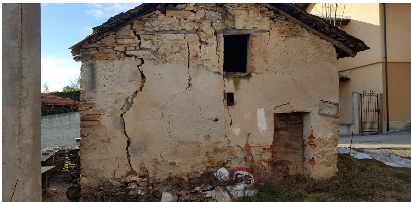
Fabbricato "A" lato retrostante.
