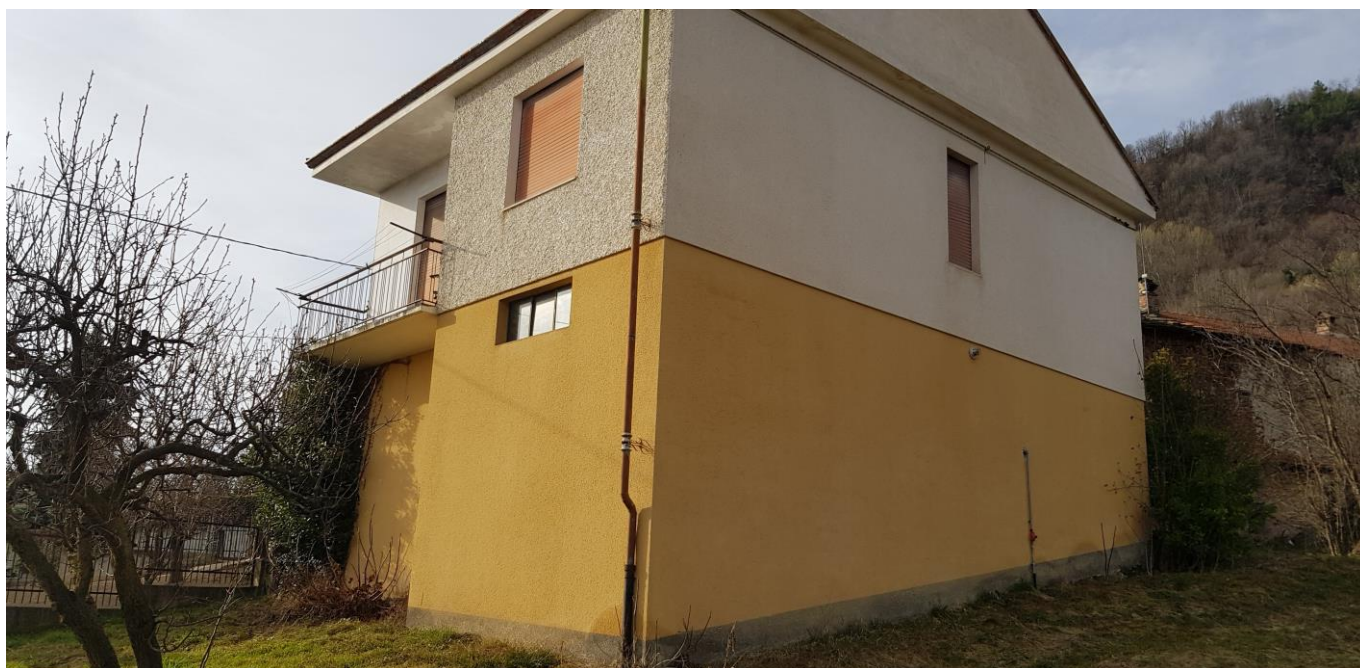
Fabbricato "C" lato via Nittardi.
