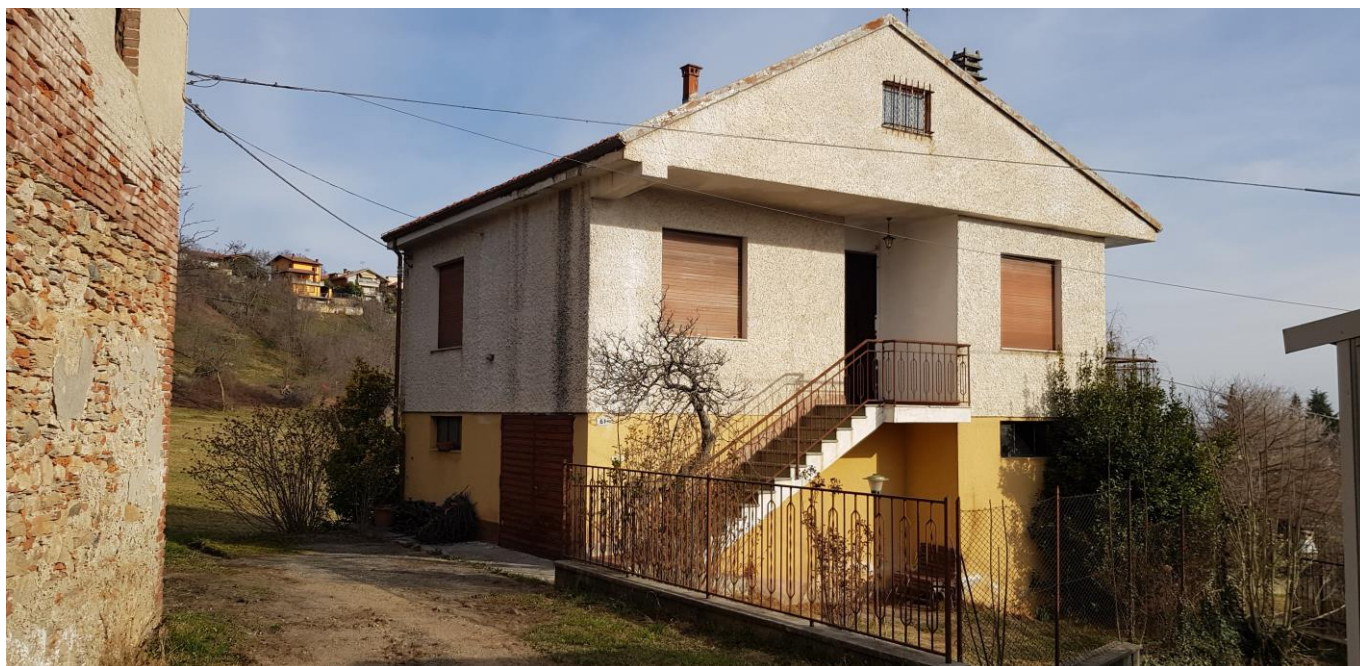
Fabbricato "C" lato via Nittardi.
