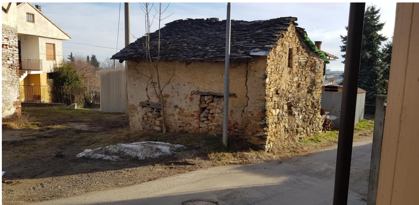
Fabbricato "A" lato via Nittardi.
