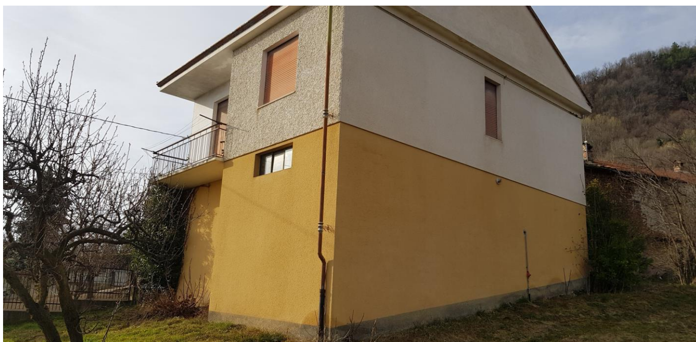
Fabbricato "C" lato via Nittardi.
